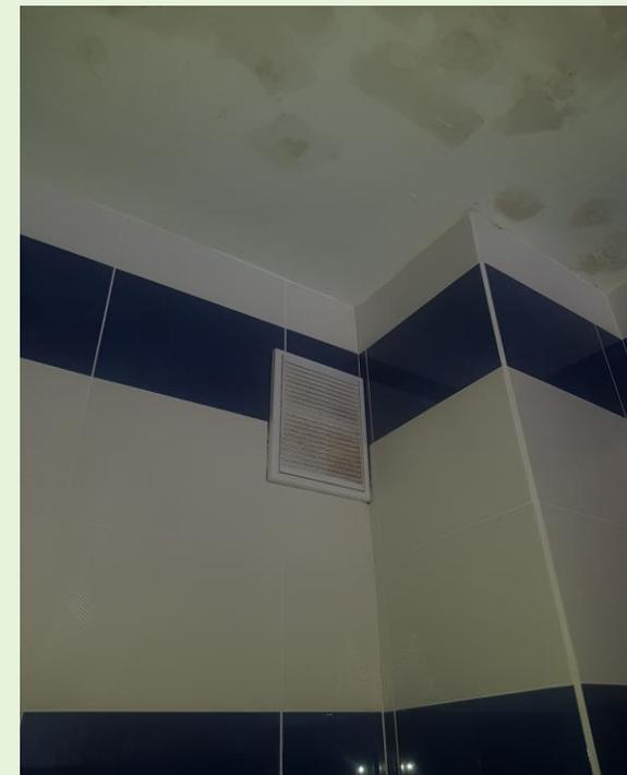
**Поверхности помещений объекта содержались в неисправном состоянии и не поддерживались в чистоте: затеки на потолке, пыль на вентиляционной решетке.**
