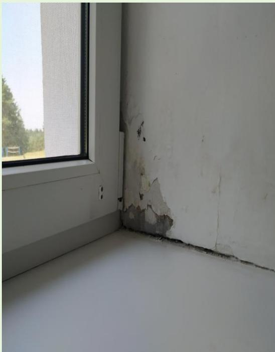
**Поверхности помещений объекта содержались в неисправном состоянии: дефекты внутренней отделки оконных проемов в душевой Шарко**
